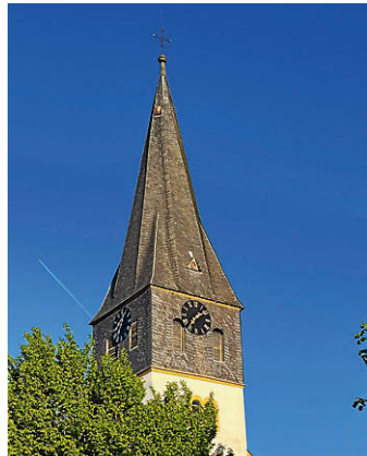
Die Kirchturmuhren wurde instand gesetzt – am 15.5. wird gefeiert Foto: agp
