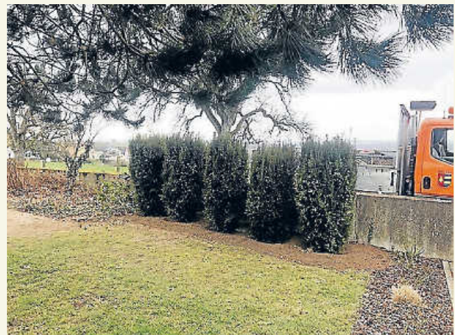
Friedhof Kälbertshausen: Pflanzarbeiten
