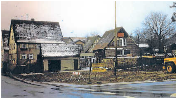
Nach dem Abbruch z.B. 1983
