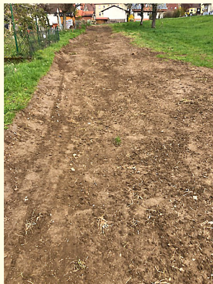
Muldenförmiger Ausbau Feldweg Bangert
