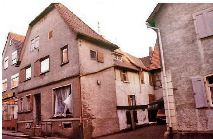
Lamm kurz vor dem Abbruch
