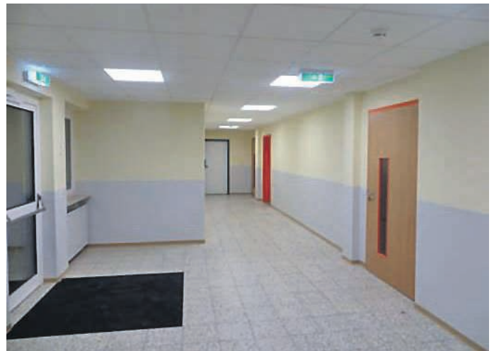
Flur nach der Sanierung
