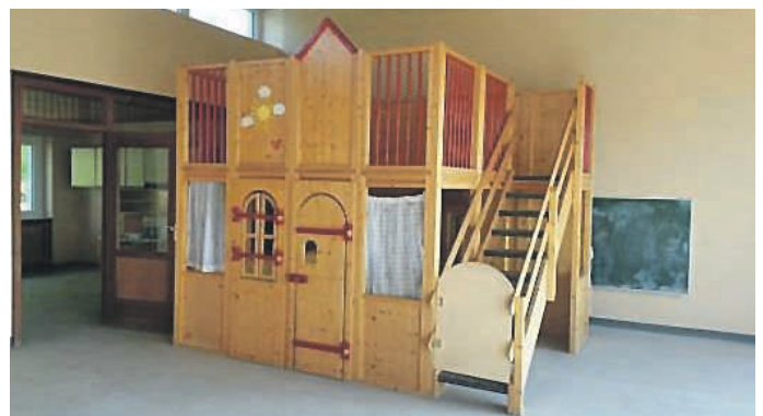
Hinterer Gruppenraum, künftiger Gruppenraum für 3- bis 6-Jährige vor der Sanierung
