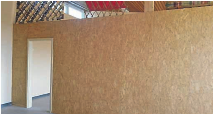
Früherer Turnraum, künftiger Gruppenraum für Kleinkinder vor der Sanierung
