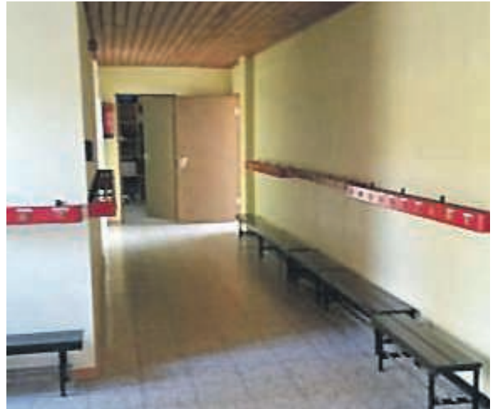
Flur vor der Sanierung
