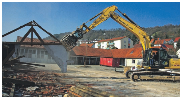
Bürgermeister Neumann bewies sein Geschick am Steuerknüppel des Baggers
