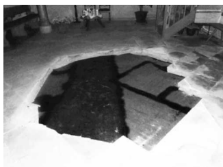
Versiegelung mit Bitumen
