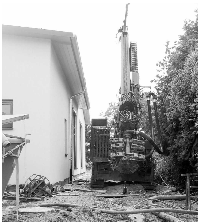
Bohrmaschine nach der ersten von fünf Bohrungen
